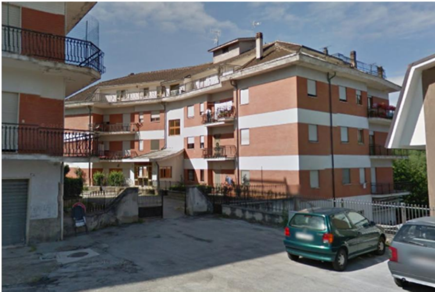
Situazione pre sisma
