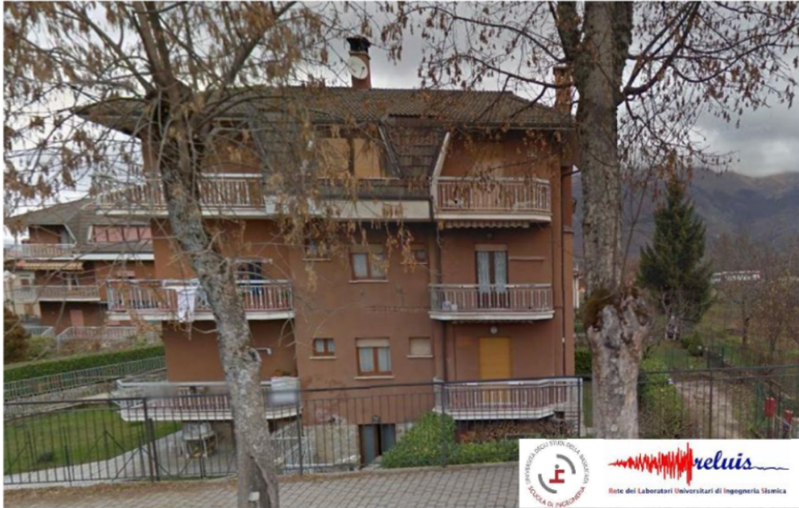
Situazione pre sisma
