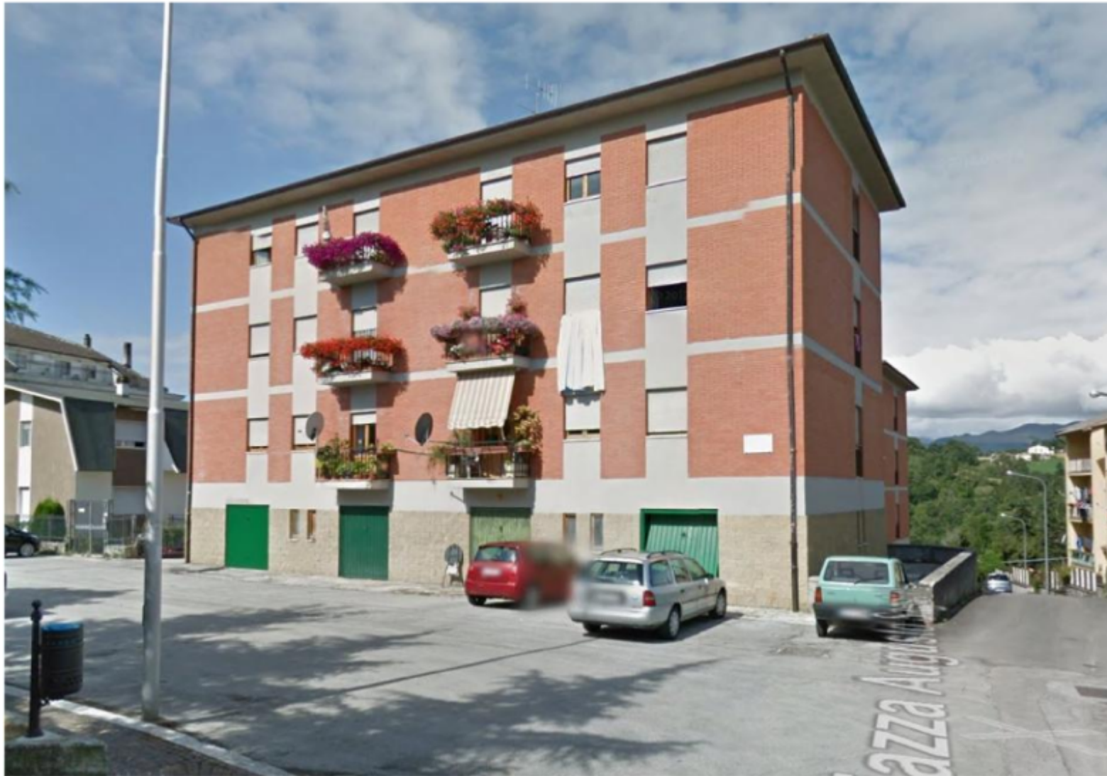
Edifici C2 e C2A : cemento armato, 4 impalcati
