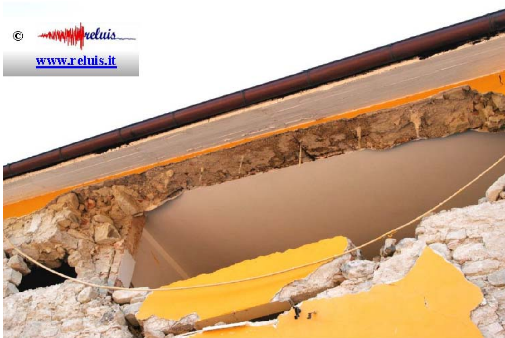
Edificio in muratura - Accumoli
