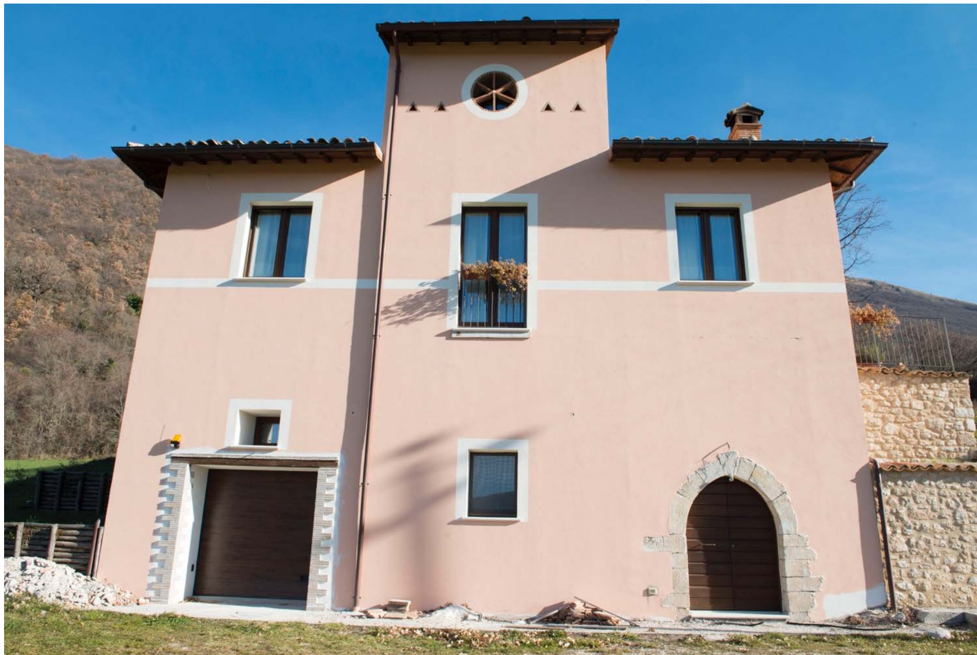
una casetta di recente costruzione in blocchi poroton
