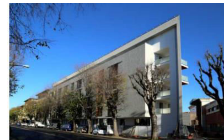
Complesso edilizio completato – Lato Viale Giannotti
