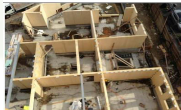
Porzione di edificio con pareti XLAM montate
