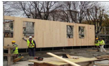
Montaggio parete XLAM
