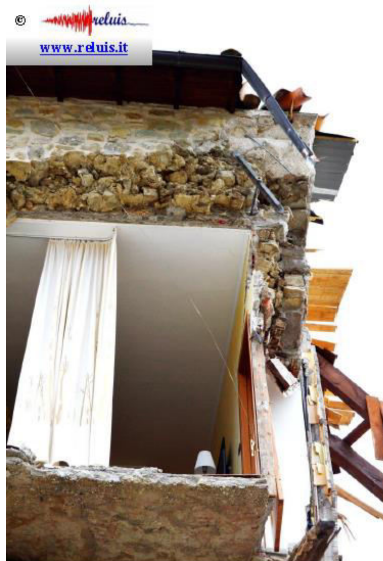
Edificio in muratura – Arquat del Tronto
