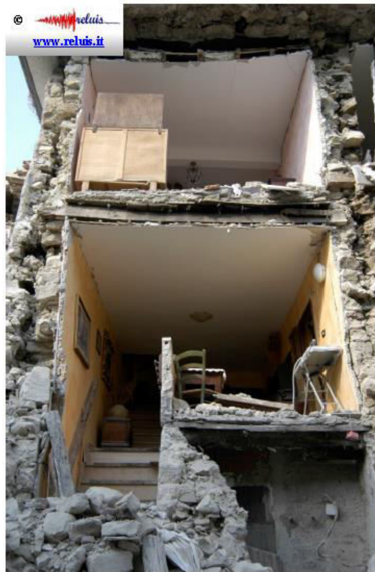
Edificio in muratura - Amatrice parete muraria e messa in luce della sezione trasversale della muratura (doppio para scarsamente ammassati trasversalmente).
