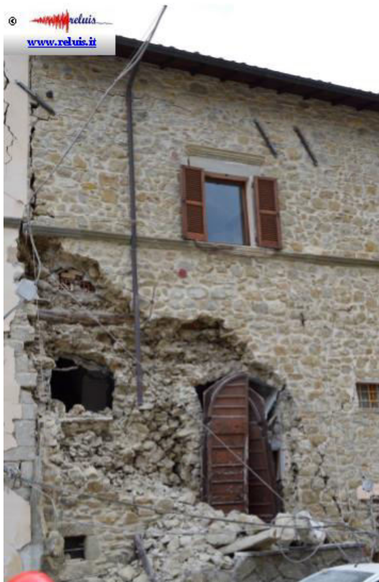
Edificio in muratura – Arquat del Tronto
