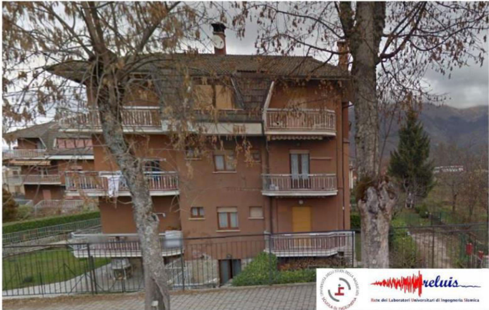
Situazione pre sisma
